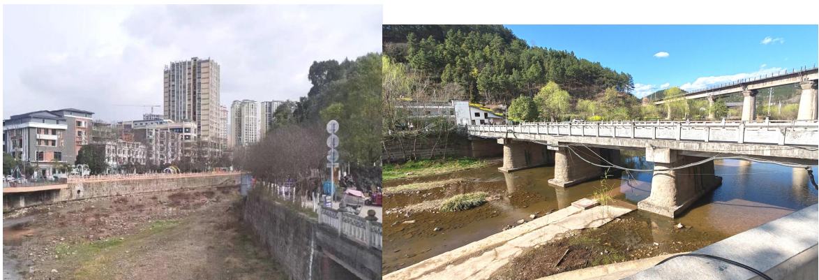
图 4-1 长滩河行洪通道整治工程现状
