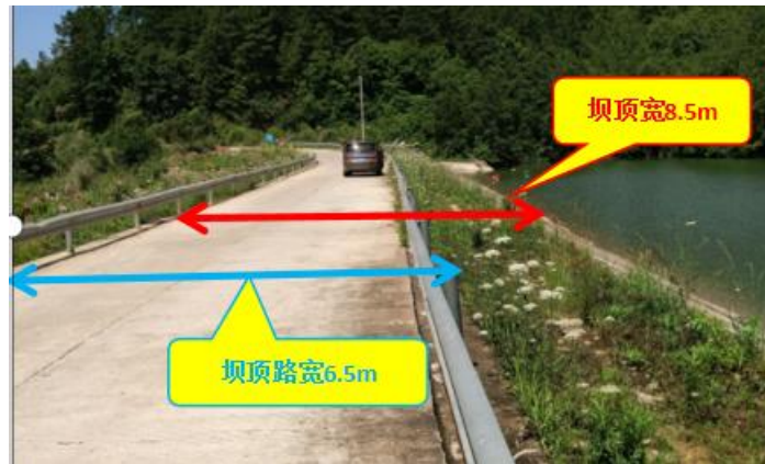
图 2-6 汤家湾水库坝顶路现状
