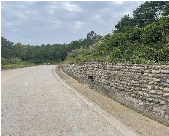
既有浆砌路堑墙
